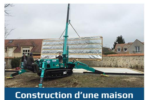
Première mini grue à conducteur embarqué, la mini grue MC305-2 combine des dimensions réduites avec une puissance importante : Capacité jusqu'à 3 tonnes pour 1280 mm de large. Conçue pour être performante dans la durée, la mini grue MC305-2 est un investissement locatif intéressant pour tous types d'utilisateurs.
