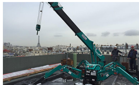
Chantier sur un toit
