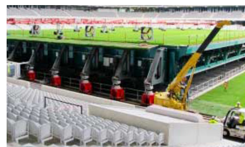
Chantier dans un stade
