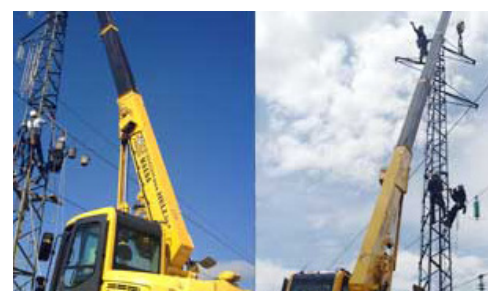
Manutention ligne haute tension
